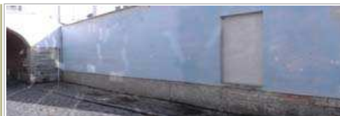
blinde muur Klemenswerk 12,15m
