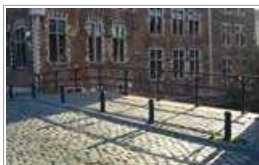
brug over de Lieve
